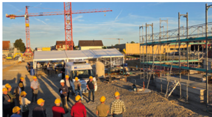
Urs Laib, Laib Bauplanungen (weisser Helm), erläutert das nachhaltige Projekt Werkhof des Kanton Thurgau in Amriswil. Bild: Werner Lenzin
