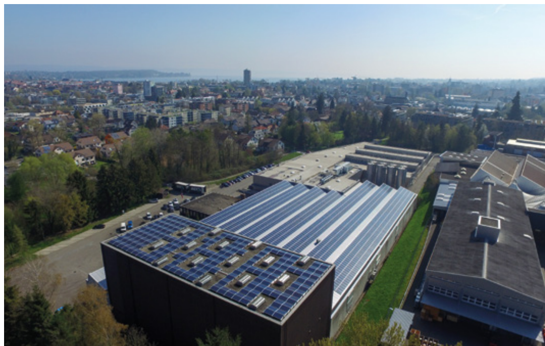
Energieeffizienz und erneuerbare Energien im Fokus: Der Produktionsstandort der Kunststoff-Packungen AG mit grossflächigen Photovoltaik-Eigenverbrauchsanlagen.
